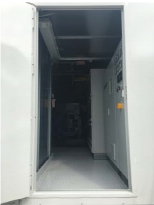
Bild 16: Einfachtüre, Boden, Schaltanlage, Kulissen (linksseitig)
