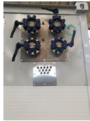
Bild 15: Rohr/Kabeldurchführung, außen
